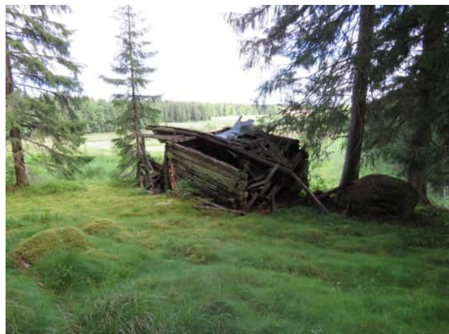
Romahtanut lato pellon reunassa, kuva pohjoiseen.
